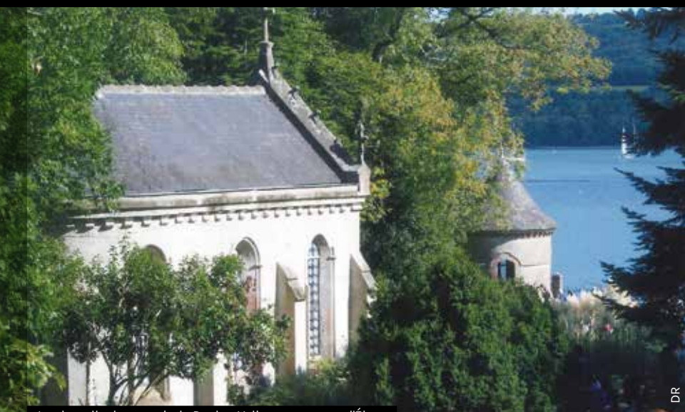
La chapelle du manoir de Poul ar Velin avec vue sur l'Élorn
