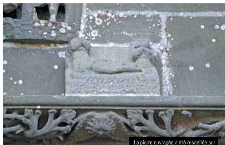
La pierre ouvragée a été rescellée sur la corniche début novembre 2015
