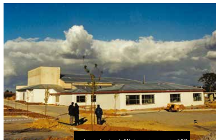
La construction de l'Alizé, premier semestre 2001
