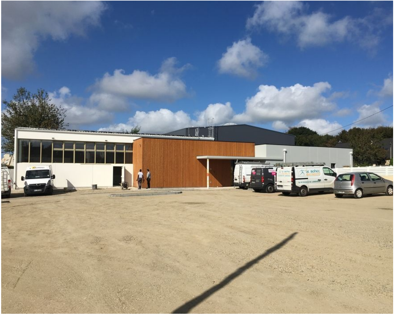
Le nouveau bâtiment - Octobre 2023
