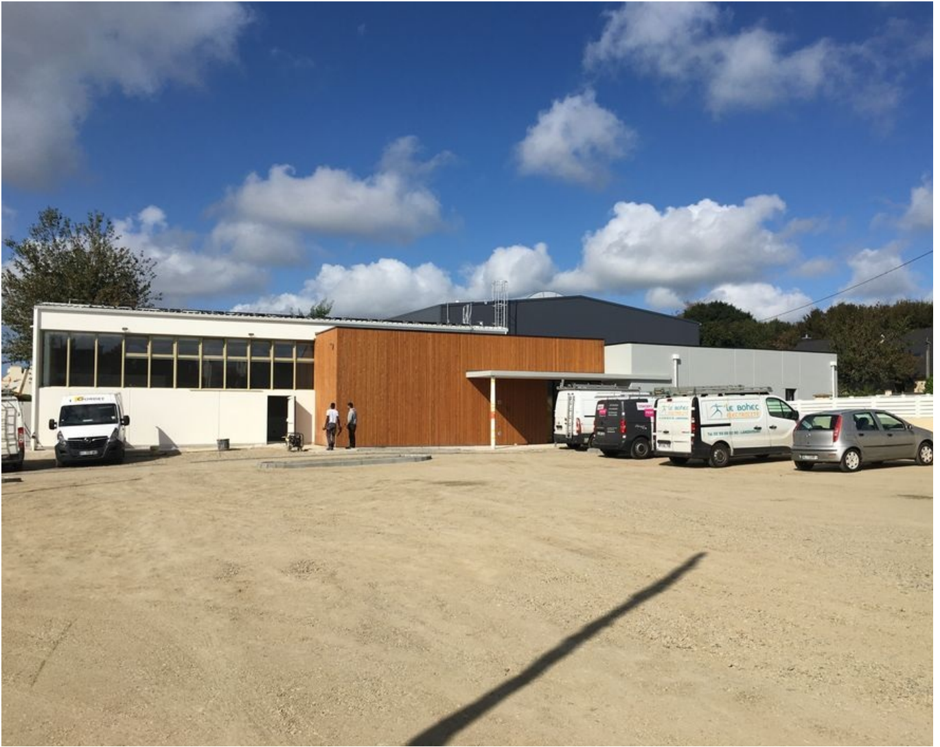
Le nouveau bâtiment - Octobre 2023
