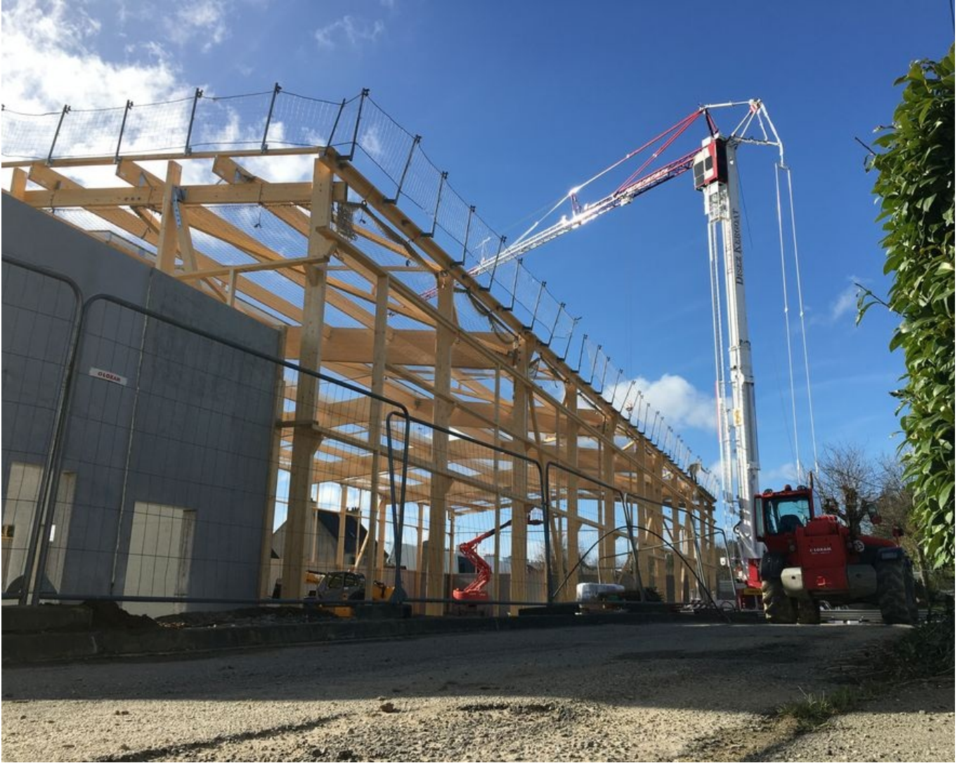
Construction du nouveau bâtiment Mars 2023 © Ville de Guipavas
