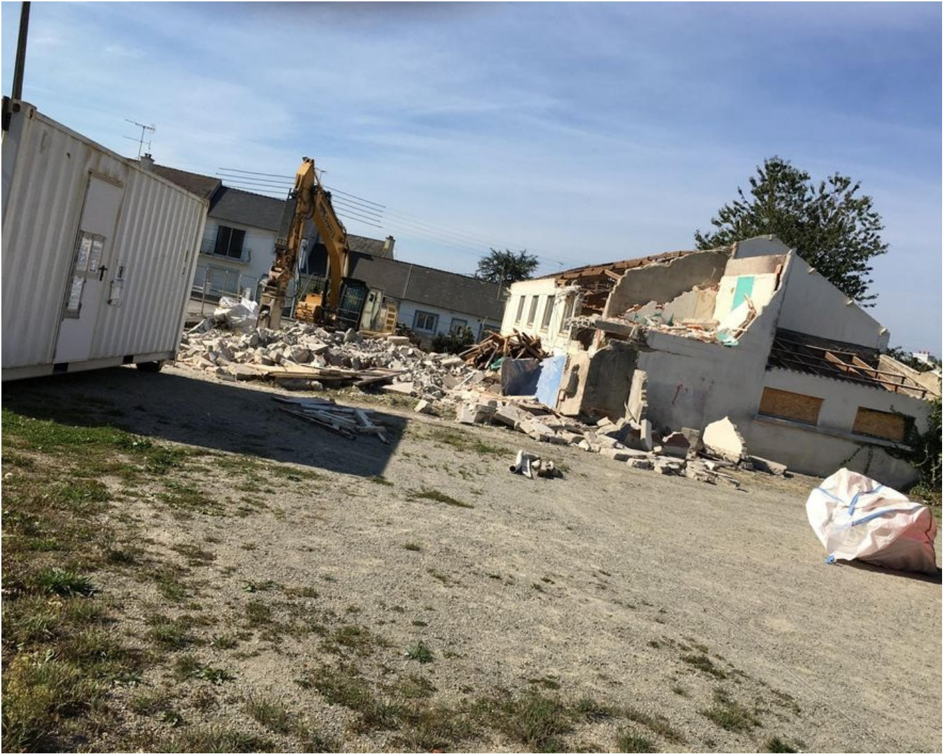
Déconstruction de l'ancien bâtiment Septembre 2022 © Ville de Guipavas
