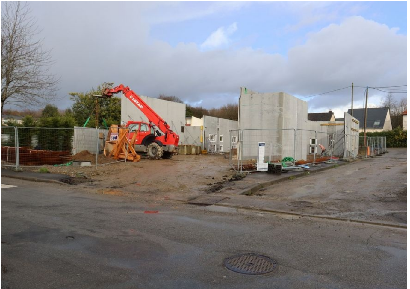
Construction du nouveau bâtiment Janvier 2023 © Ville de Guipavas
