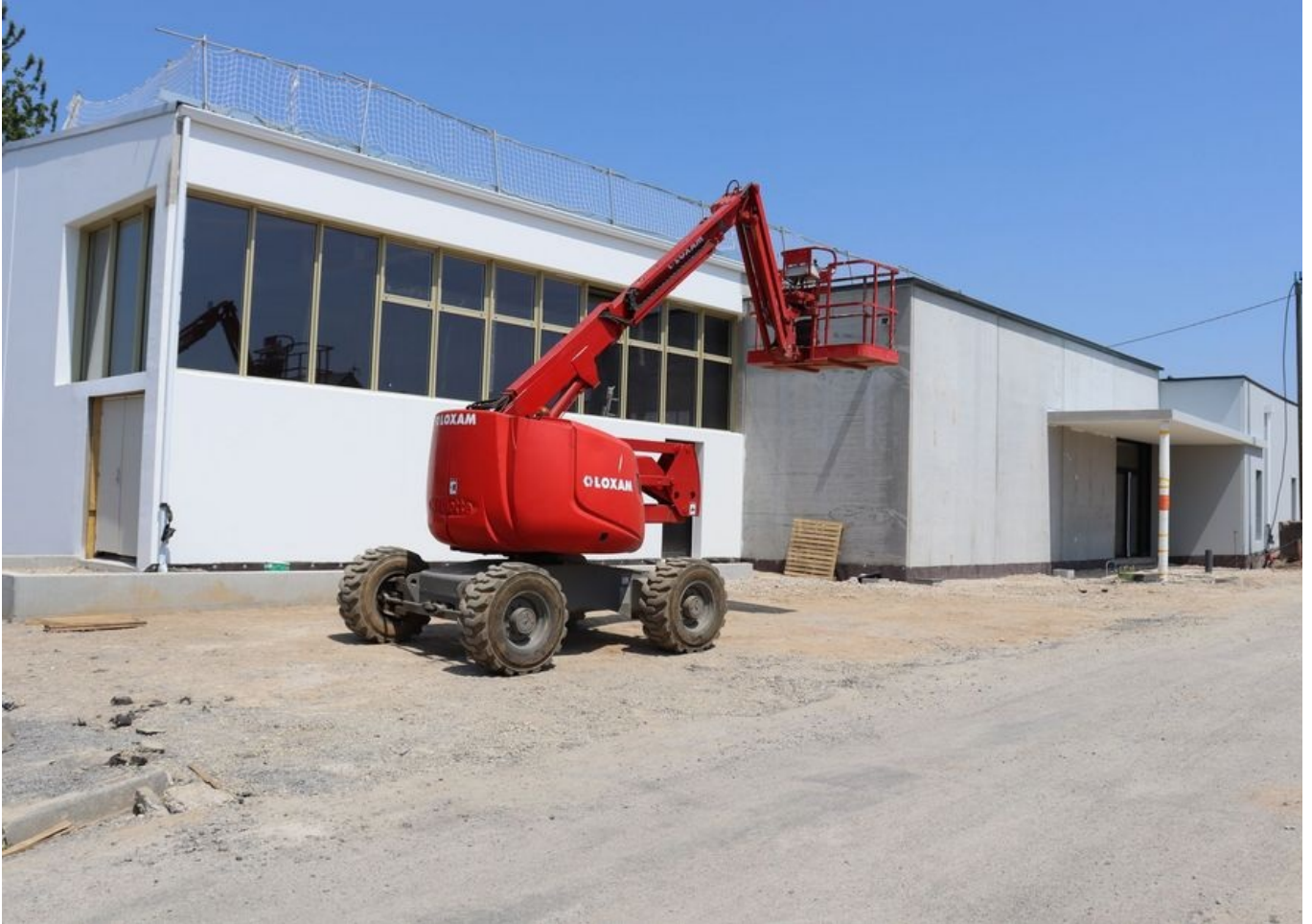
Construction du nouveau bâtiment Juin 2023 © Ville de Guipavas
