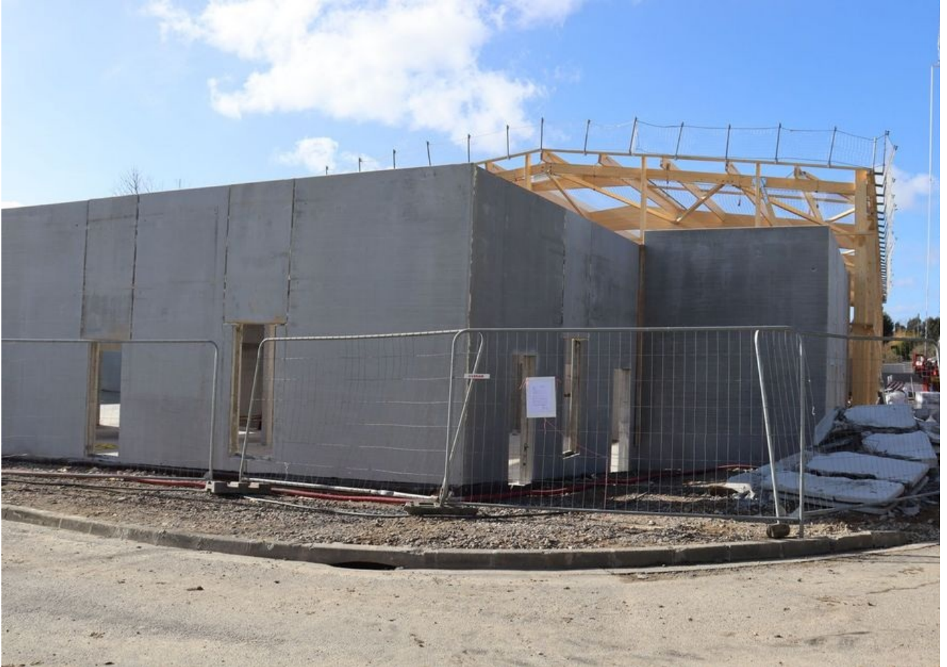
Construction du nouveau bâtiment Mars 2023 © Ville de Guipavas
