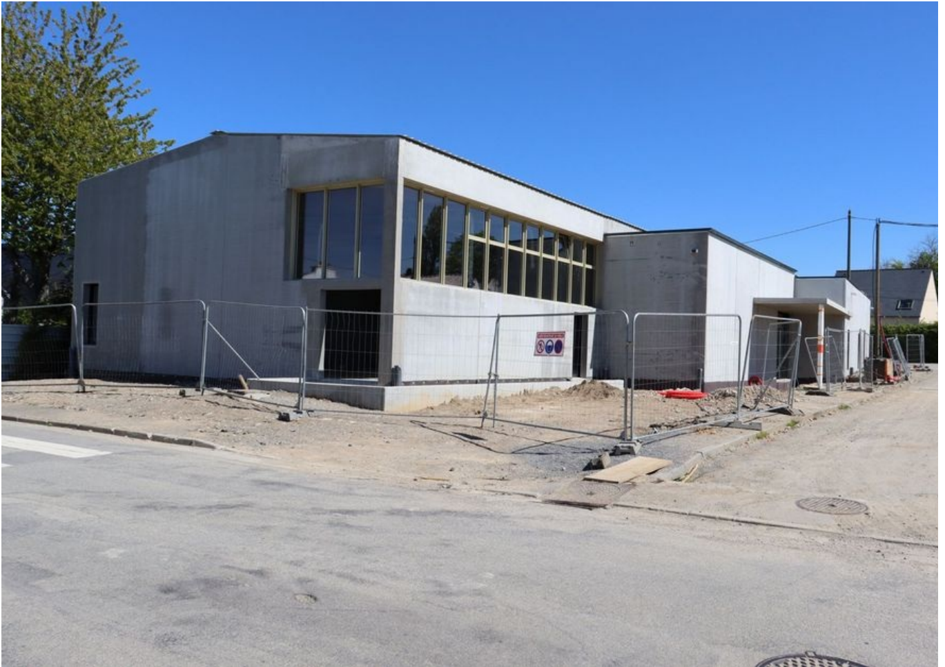
Construction du nouveau bâtiment Mai 2023 © Ville de Guipavas
