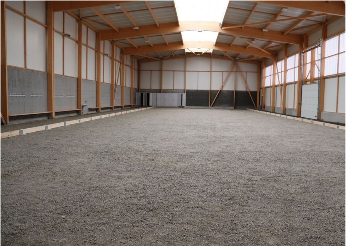
Construction du nouveau bâtiment Décembre 2023 © Ville de Guipavas
