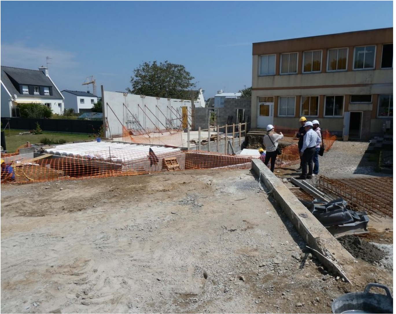
Chantier en cours - juin 2022
