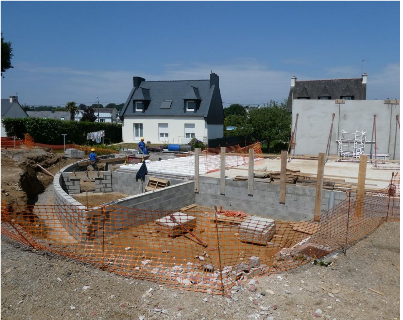
Chantier en cours - juin 2022
