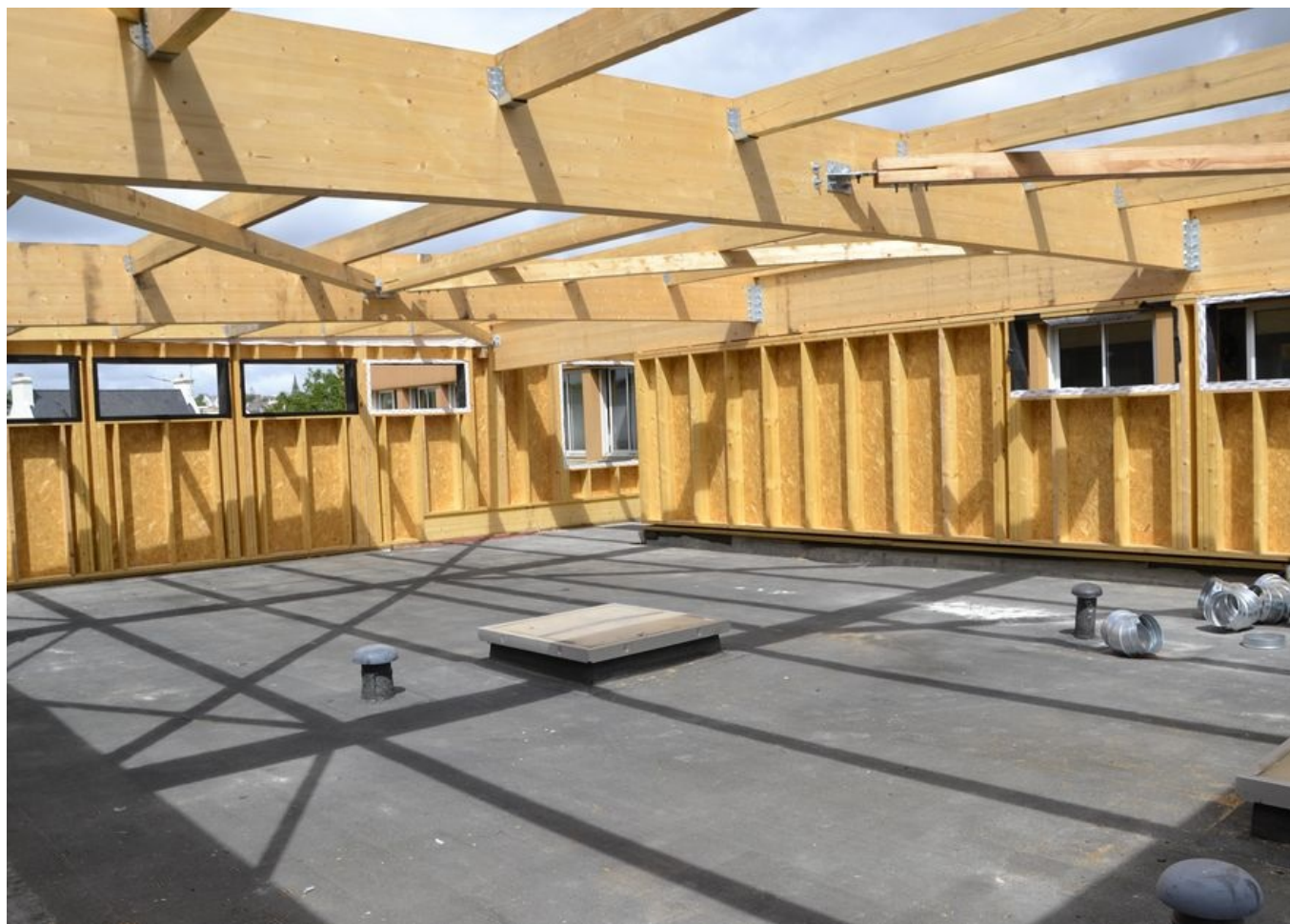
Chantier en cours - juillet 2022
