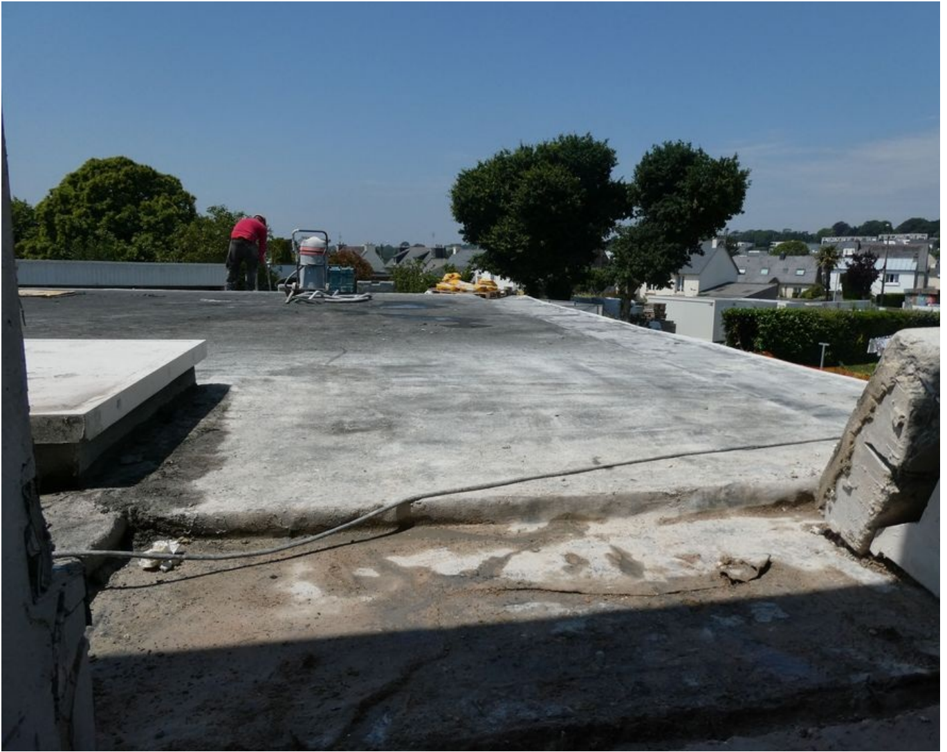
Chantier en cours - juin 2022
