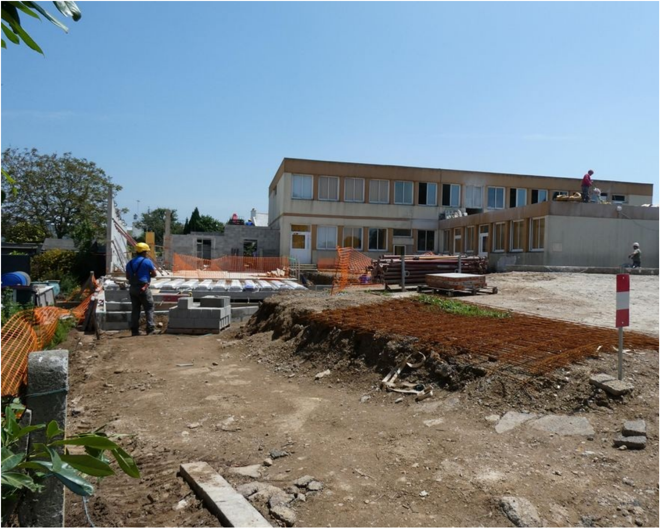
Chantier en cours - juin 2022
