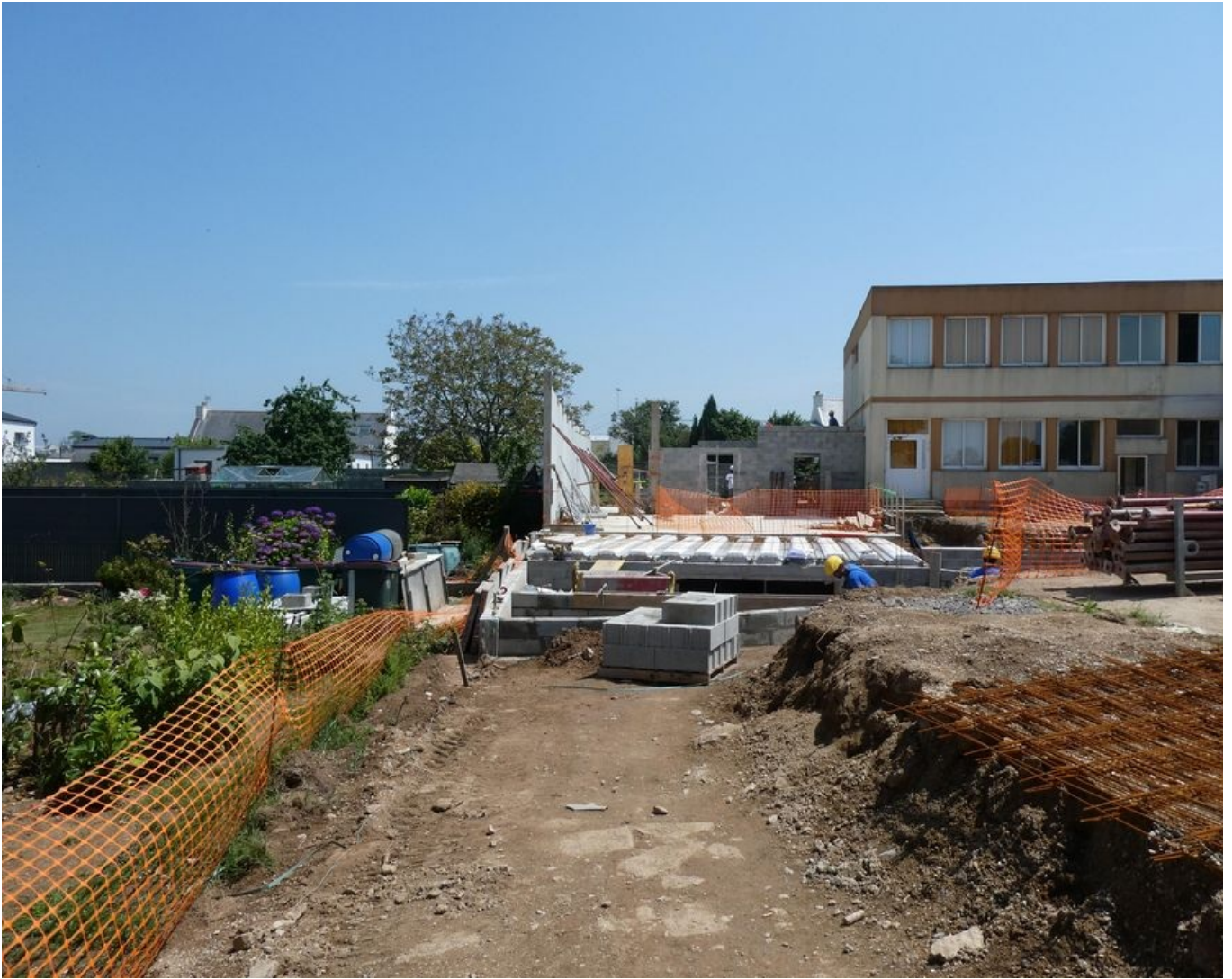
Chantier en cours - juin 2022
