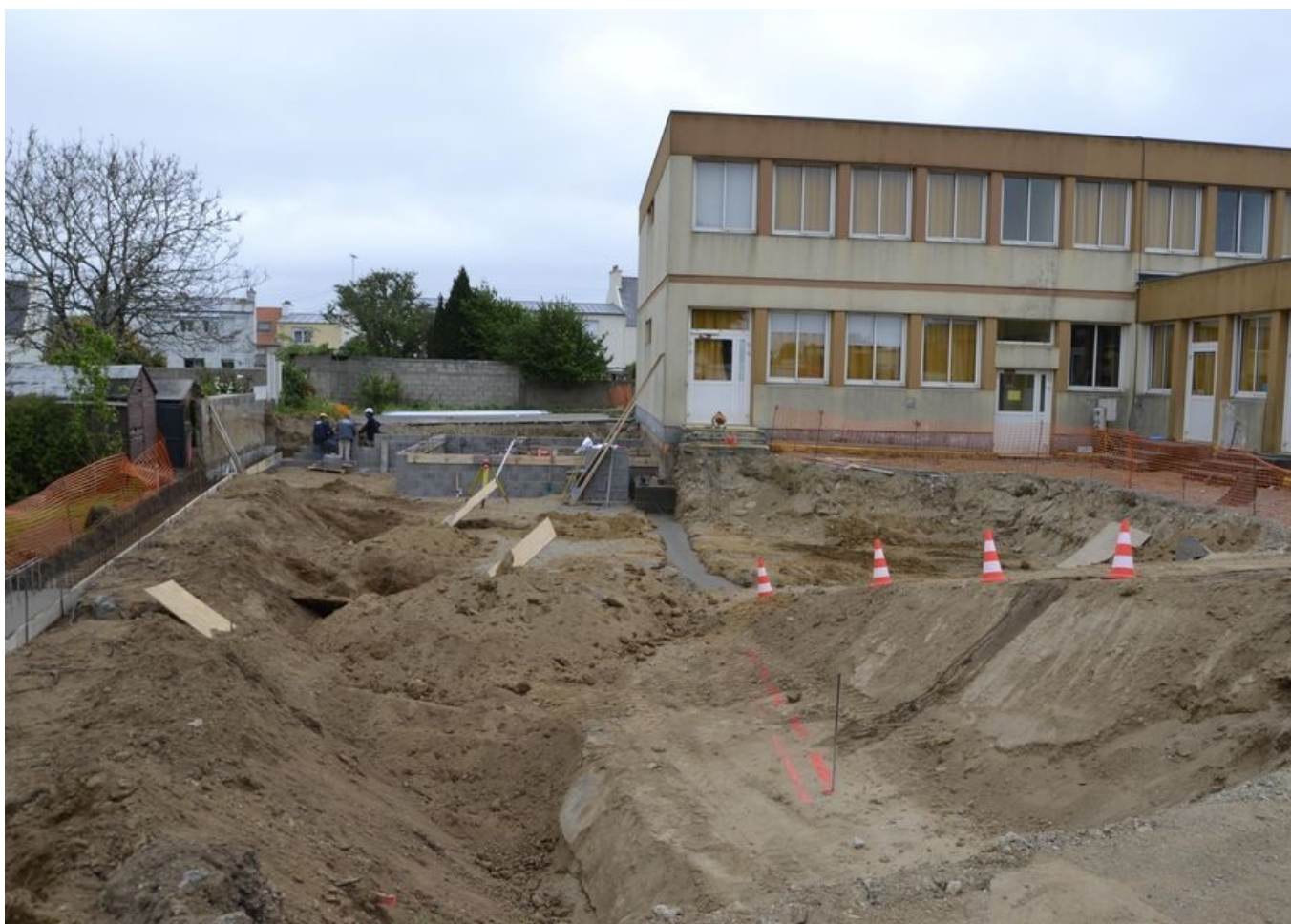
Chantier en cours - mai 2022
